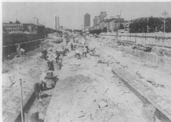
施作顶板土模
