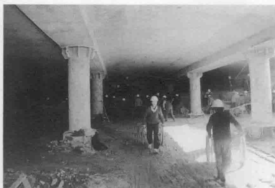
开挖车站顶层土方
