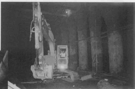
车站隧道内土方机械开挖
