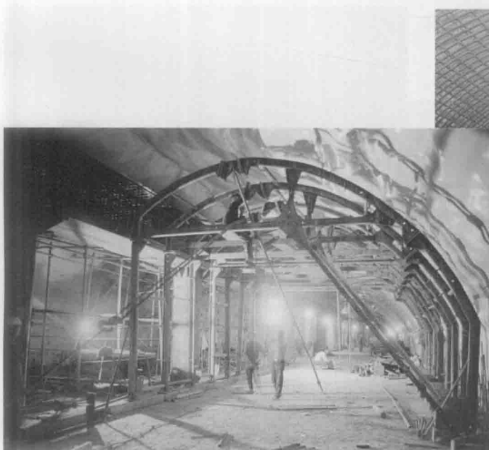
架立拱部二次衬砌模板支架
