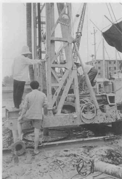
钻孔施作中柱桩基础
