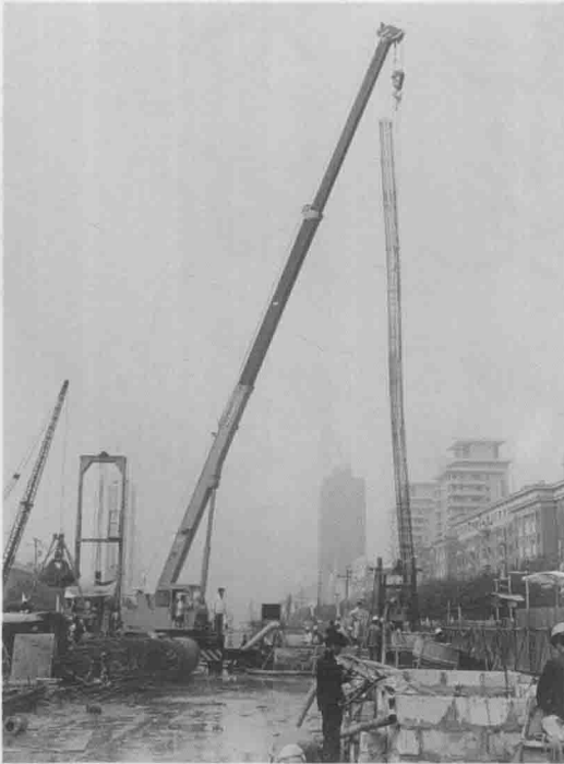
施作混凝土灌注桩吊放钢筋笼
