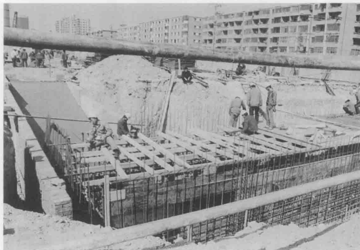
在车站出入口绑扎钢筋，立模板
