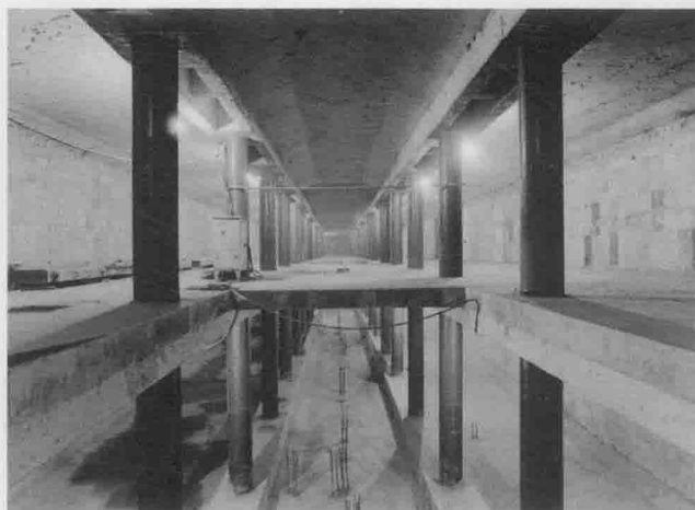
施工中的车站站厅层和站台层
