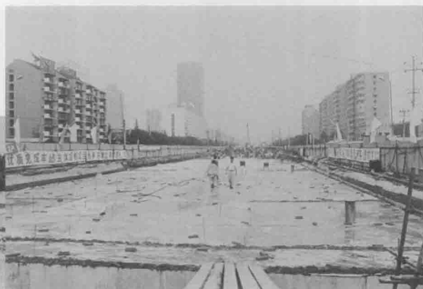
顶板混凝土浇灌完成，铺设顶板防水层
