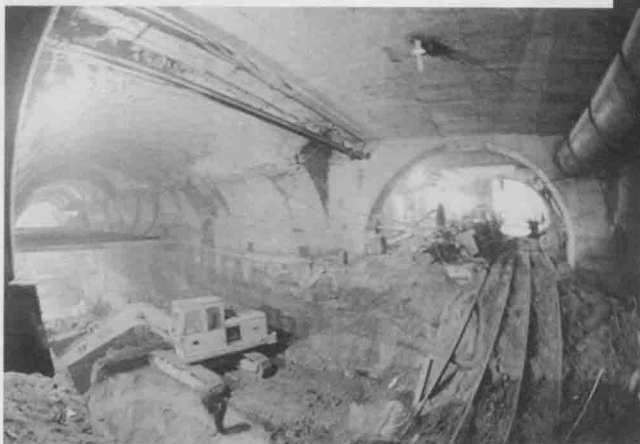
站台层土方机械开挖
