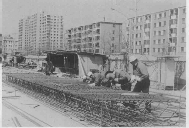
连续墙钢筋笼制作
