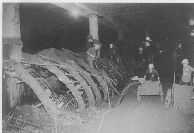
破除导坑临时支护
