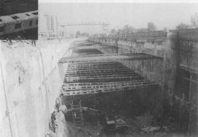
在复合支护体系支撑下进行土方机械开挖
