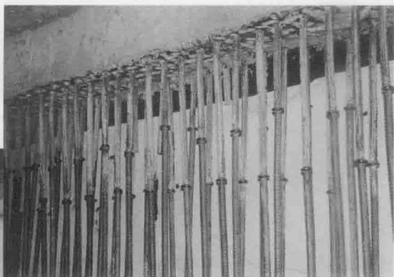
采用电渣压力焊焊接车站侧墙内衬钢筋
