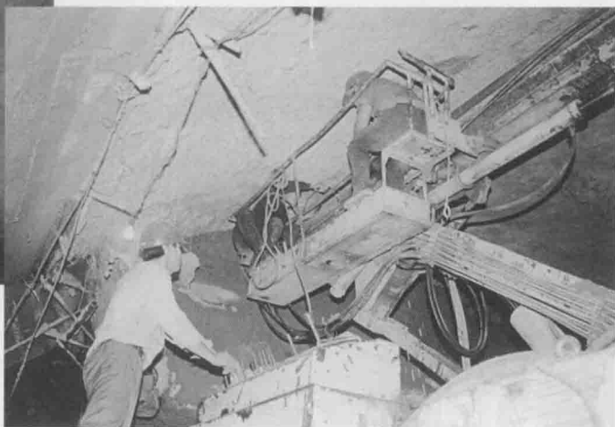
布设隧道拱部大管棚
