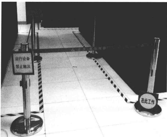
图 1-2 施工现场设置安全围栏
