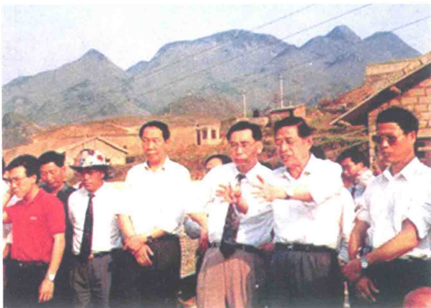
● 1994年4月8日，省长朱森林（前右三）、副省长张高丽（前右一）等到国家“西电东送”重点工程天生桥一级水电站工地视察
