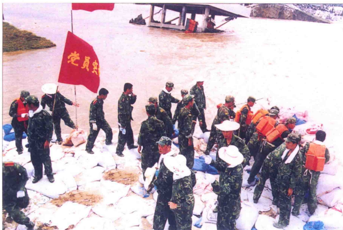
●1998年6月30日凌晨，佛山市南海区丹灶镇西江护堤发生坍塌，驻粤75200部队坦克旅650多名官兵紧急赶赴灾区参加抢险。图为党员突击队参加堵口会战
