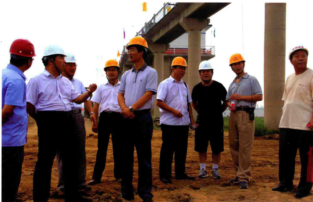
8月30日，副局长靳怀塔（右四）到牛角峪退水闸和祝官屯节制闸除险加固工程施工现场看望并慰问施工一线职工
