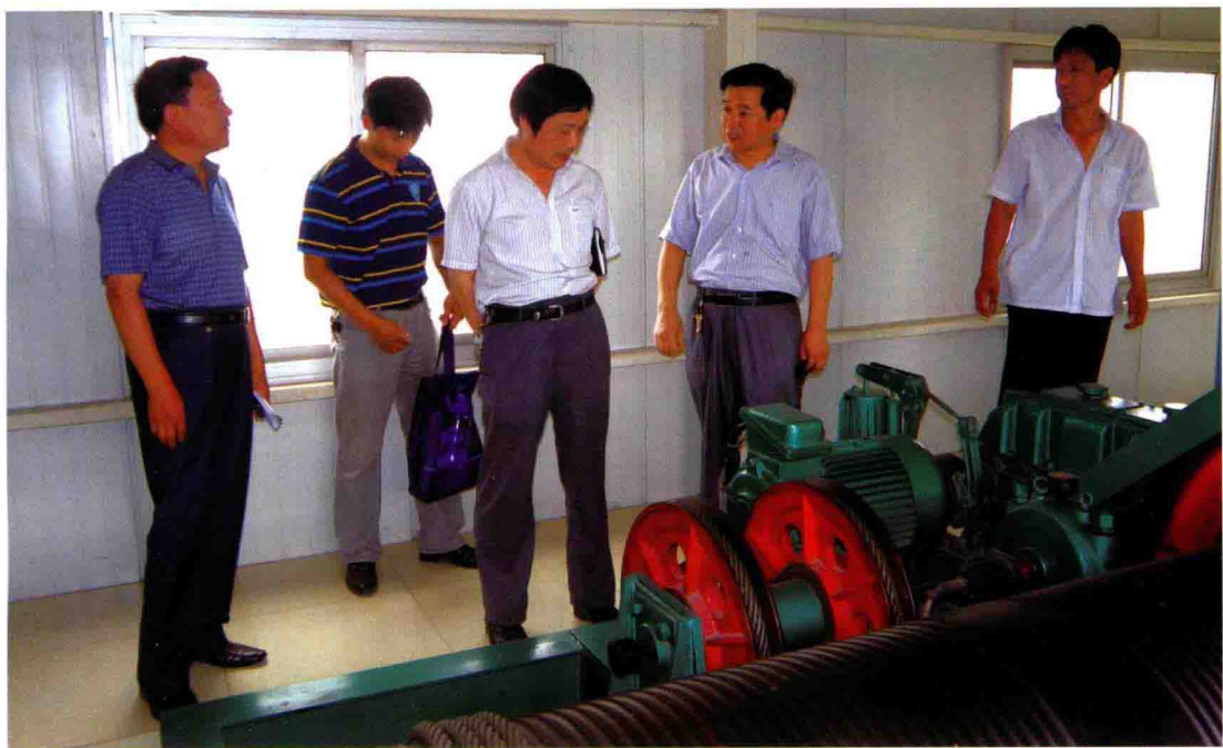
6月21日，总工徐林波（左三）到水闸管理局检查指导工作（张洪泉 摄）
