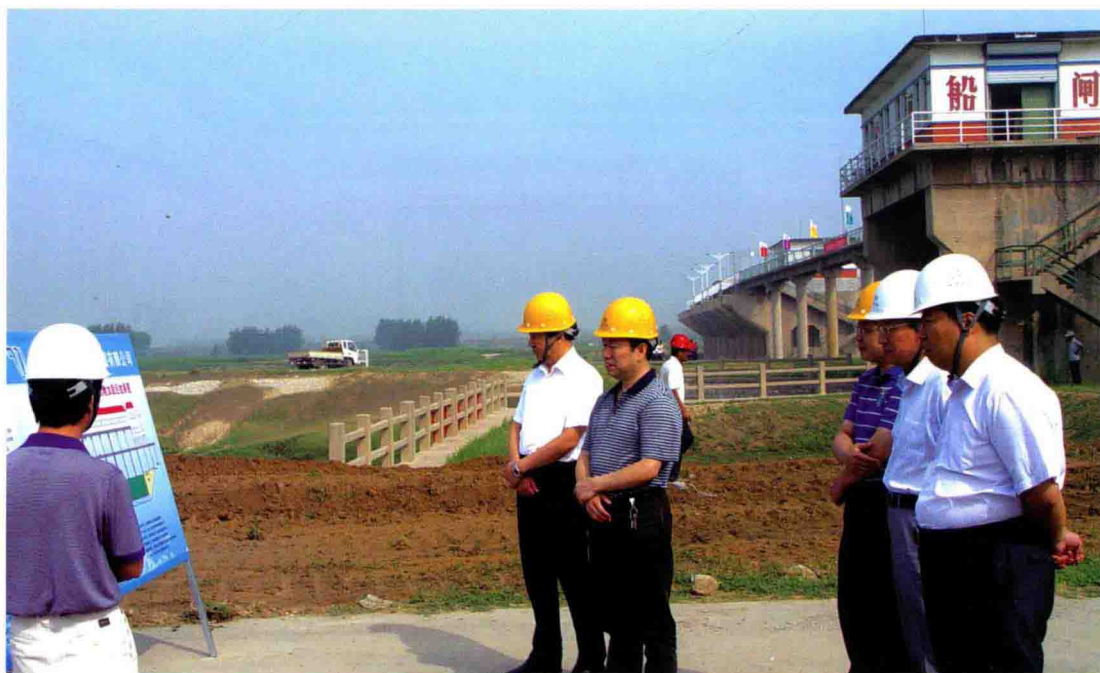
7月3日，局长张胜红（左三）检查牛角峪退水闸除险加固工程和祝官屯枢纽节制闸除险加固工程建设情况
