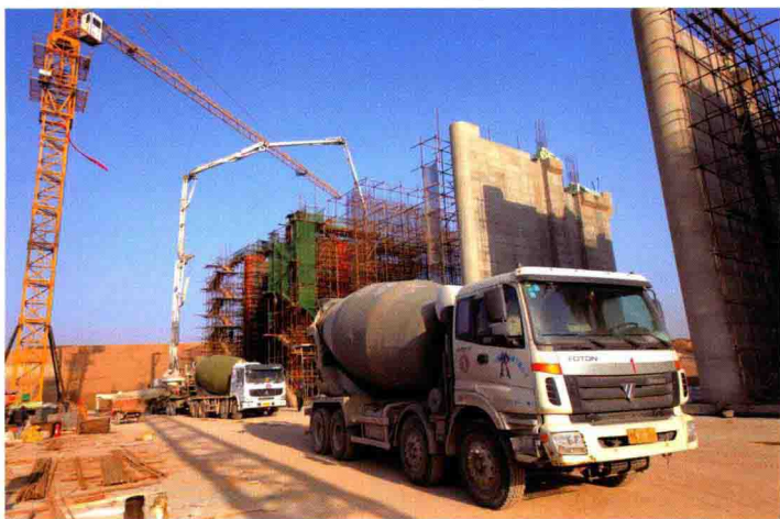
祝官屯枢纽节制闸除险加固工程
