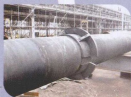
海管及法兰防腐
