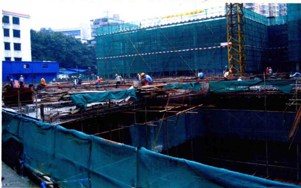
建设时的佳润广场施工现场
