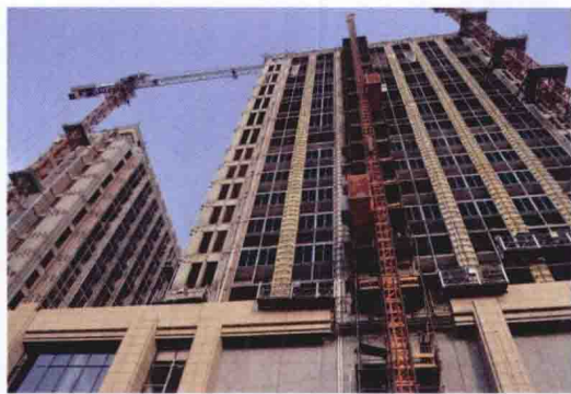
图1-12 高层商住楼施工现场
