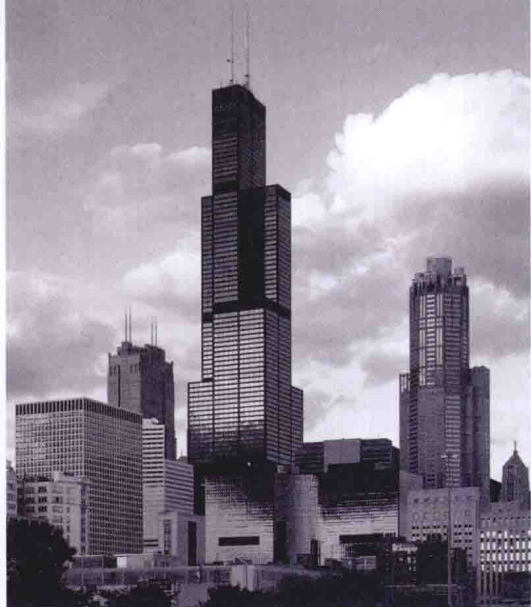
图1-8 西尔斯大厦采用成束筒结构体
