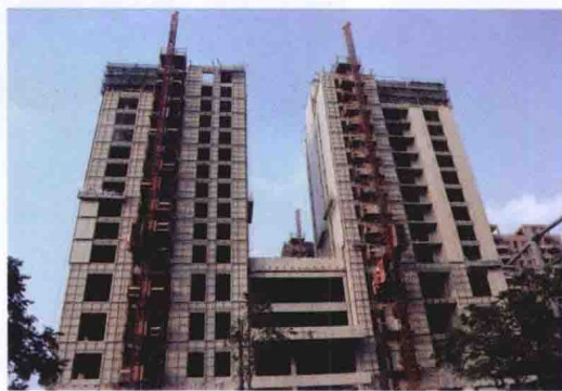
图1-13 高层住宅楼施工现场
