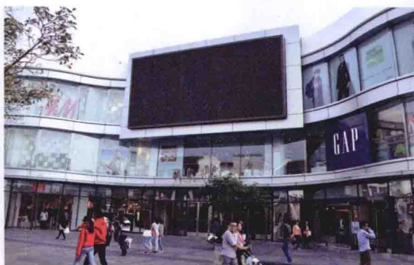
图1-11 苏州市观前街上某建筑外立面采用大面积的玻璃和铝塑板进行装饰
