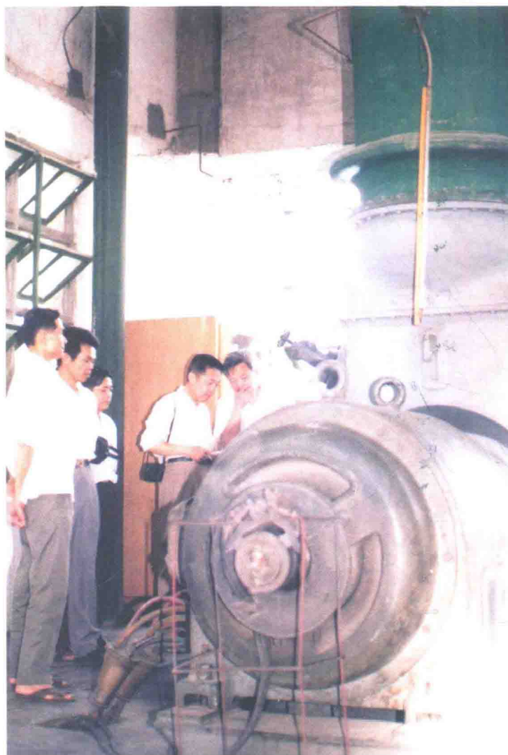
●1983年，中国科学院广州能源所在丰顺县邓屋村建设国内第一座热水型地热试验电站。该电站采用扩容闪蒸发发电系统，至2000年仍正常发电
