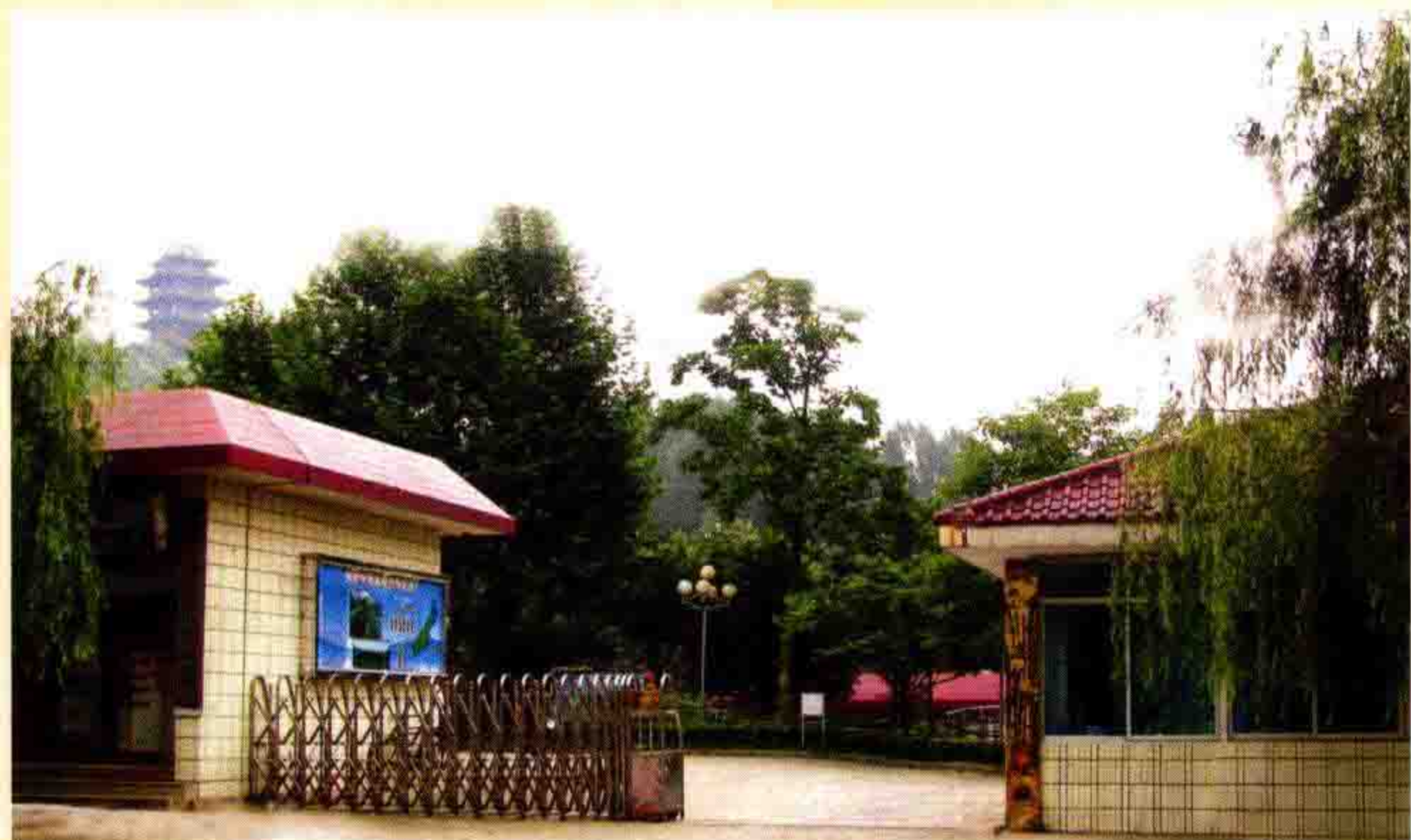
高桥污水处理厂
