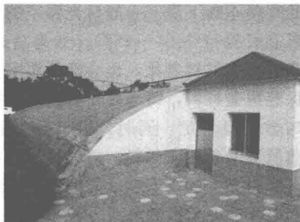
图 2-1 砖石结构日光温室
