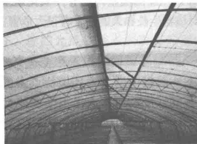
图 2-5 钢竹混合骨架塑料大棚
