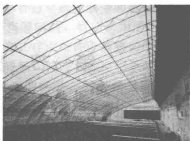
图 2-3 钢筋骨架日光温室
