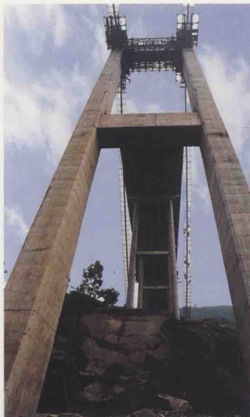
雄伟挺拔的桥塔
