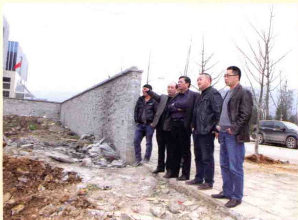
2013年2月，务川自治县县委常委、常务副县长樊建明（中）查看县工商局办公大楼施工情况
