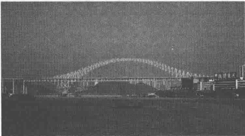
图 1-12 朝天门长江大桥
