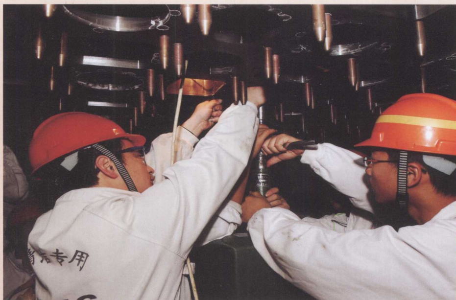
反应堆上部堆内构件安装现场
