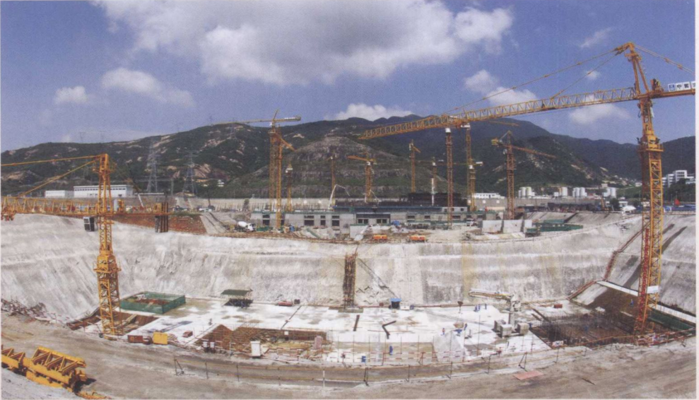
2006年9月15日，岭澳核电站二期工程1号机组常规岛基础施工
