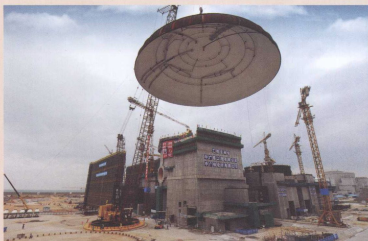
2007年9月23日，岭澳核电站二期工程1号机组安全壳穹顶吊装
