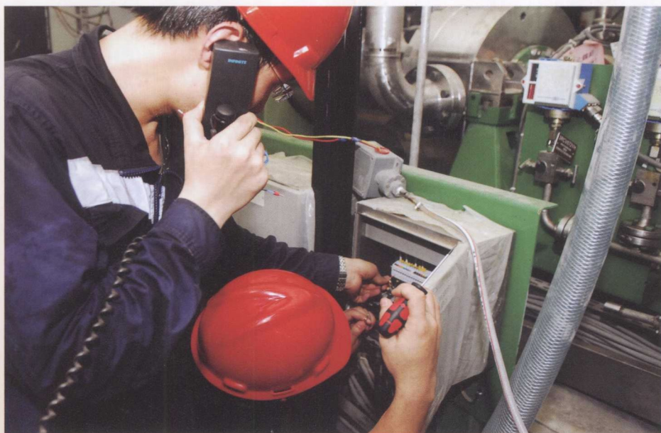
上冲泵调试现场
