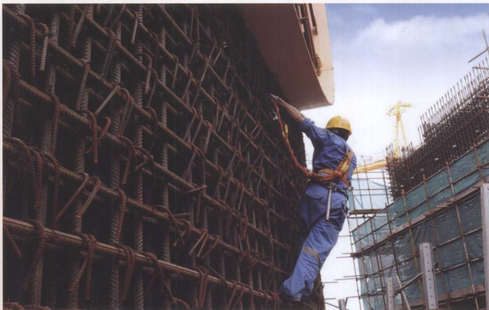
高空施工作业现场实操训练
