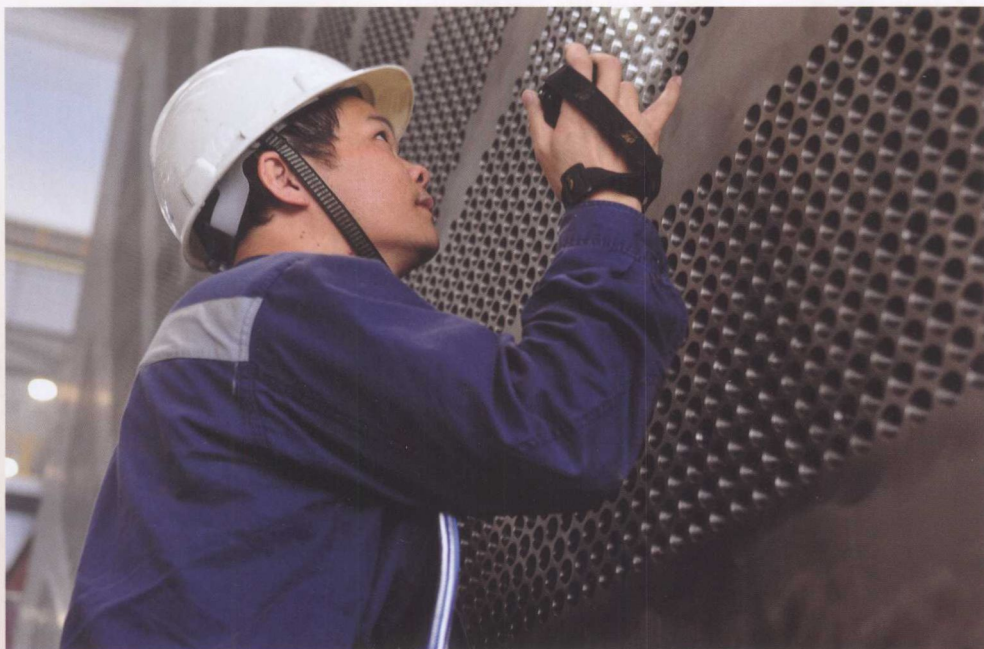
中广核工程有限公司质检人员在现场认真检查冷凝器钛管焊接质量
