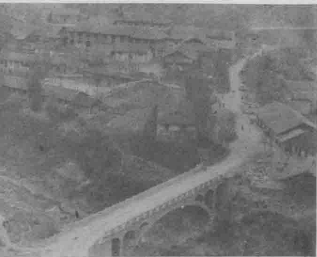
3、红四方面军总指挥部驻地（墩上） 4、红军货币（现存北川县文化馆） 5、红军用过的马灯 （现存北川县文化馆）
