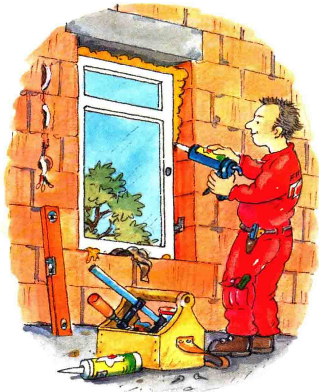
木工安装门窗。
