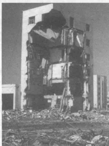
图 1.5 辽宁盘锦某办公大楼煤气爆炸事件
