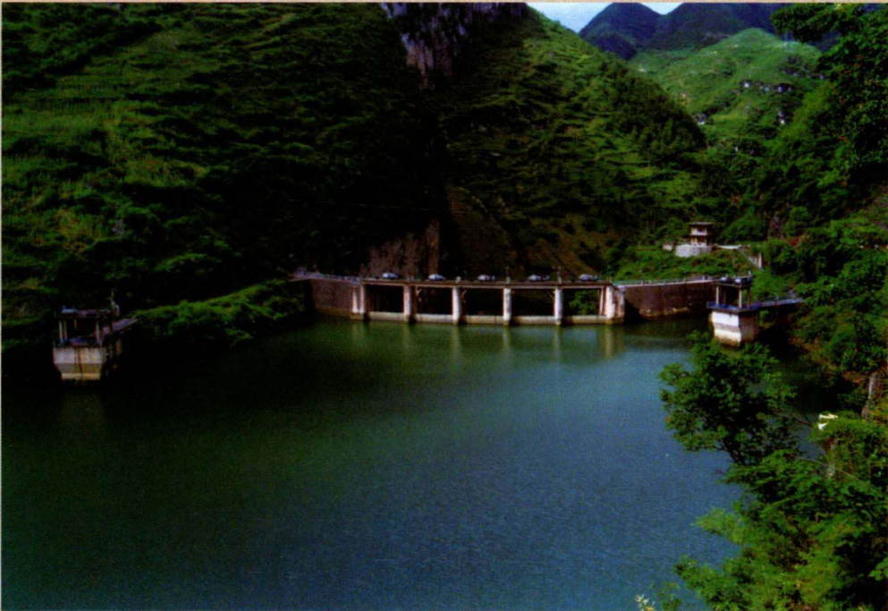
猫跳河四级窄巷子水电站，溢流式双拱坝，坝高 54.7m，于 1970 年建成
