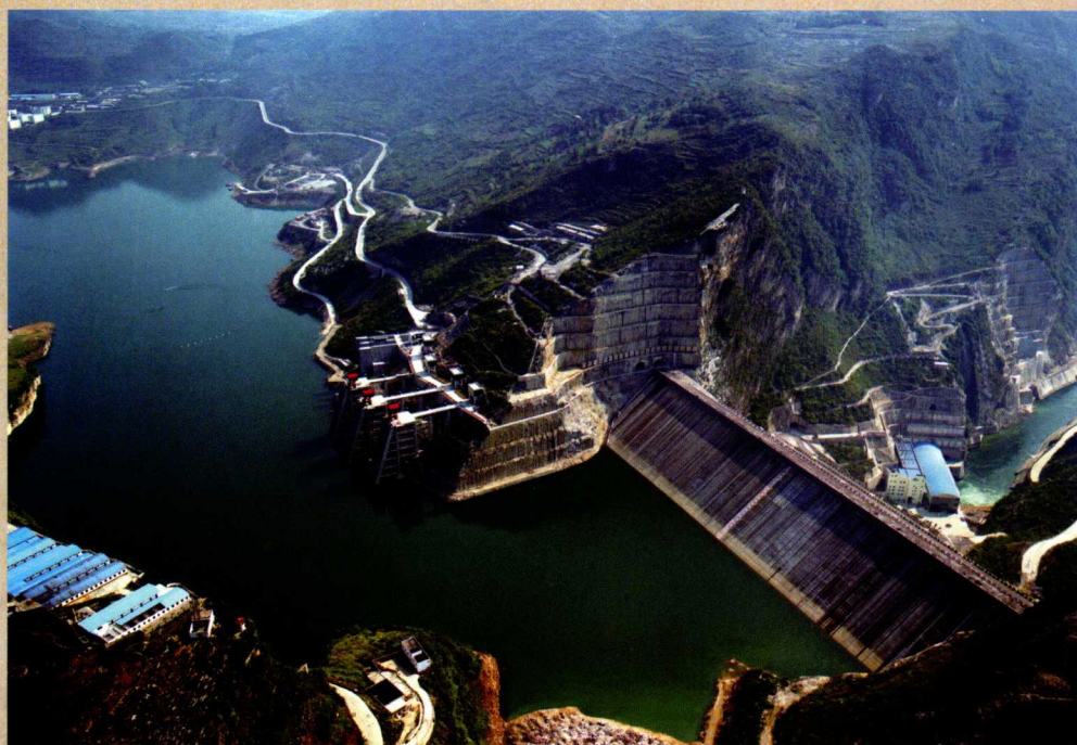
乌江洪家渡水电站，面板堆石坝，坝高 179.5m，于 2004 年建成
