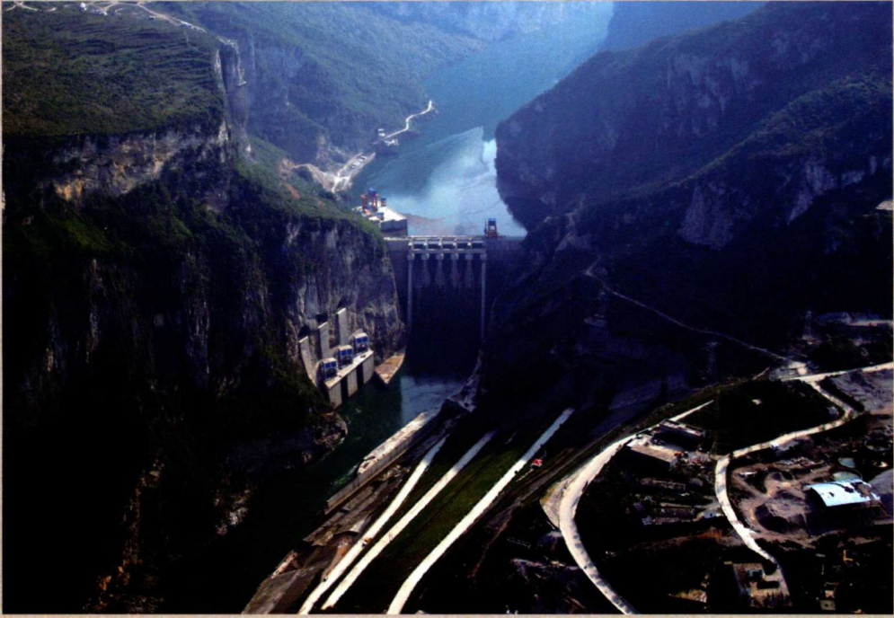
乌江索风营水电站，重力坝，坝高 115.8m，于 2006 年建成
