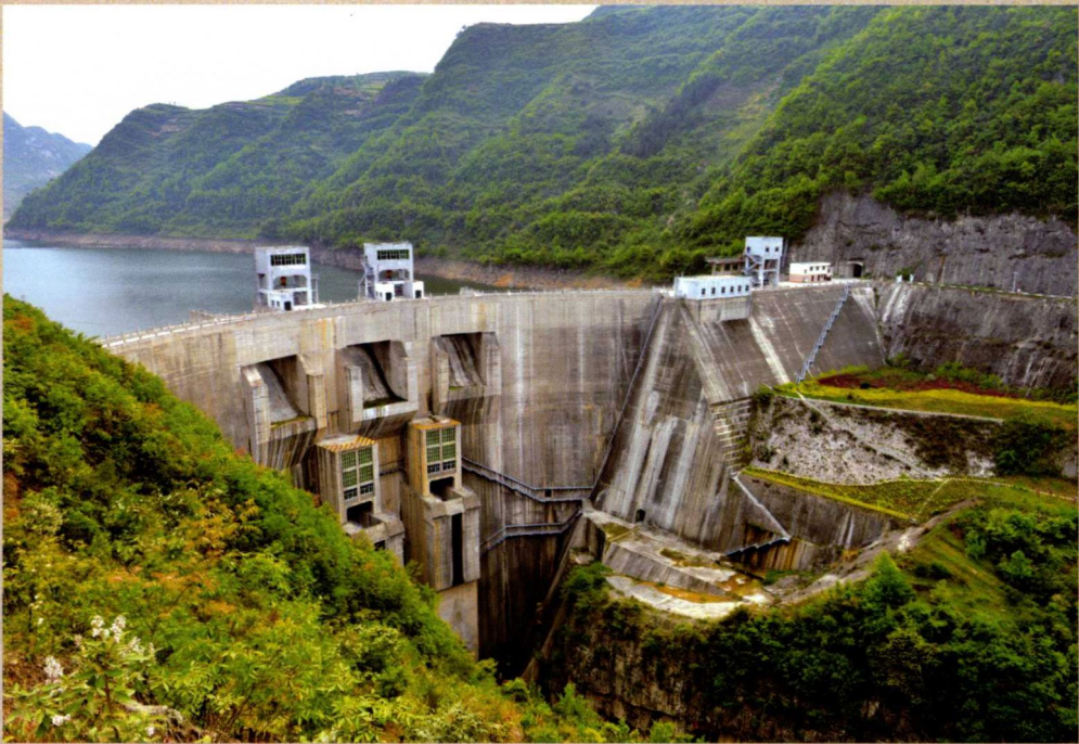
清水河大花水水电站，碾压混凝土双曲拱坝，坝高 134.5m，于 2007 年建成
