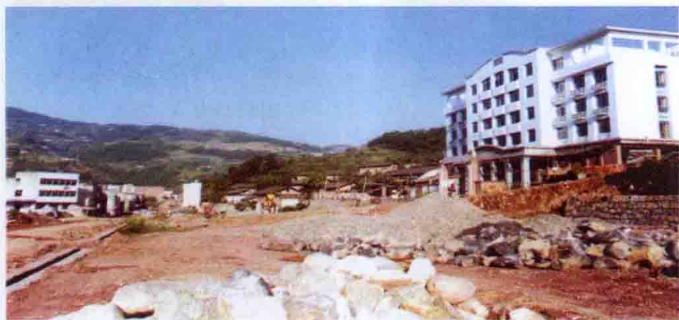
正在建设中的两河口新集镇全貌（屈智摄）
