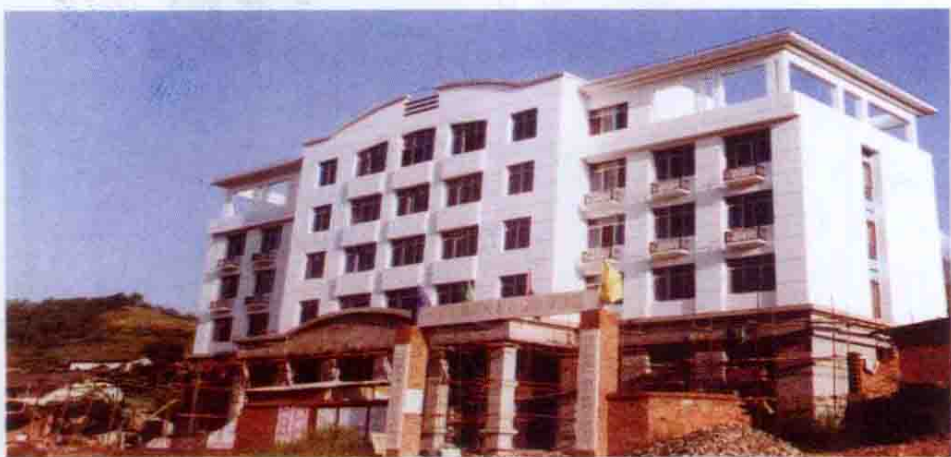
正在建设中的两河口镇政府综合办公大楼（屈智摄）
