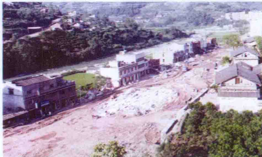
正在建设中的两河口新集镇主干道——太坪大道（屈智摄）
