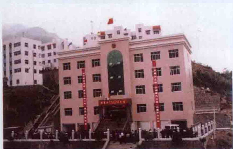
移民迁建落成的乡政府办公大楼
