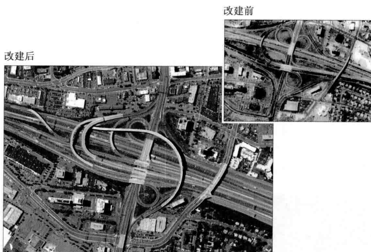
图1-7 美国I-95高速公路与城市道路相交的互通式立体交叉
