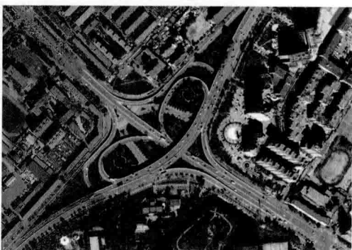
图 1-5 我国某城市互通式立体交叉
