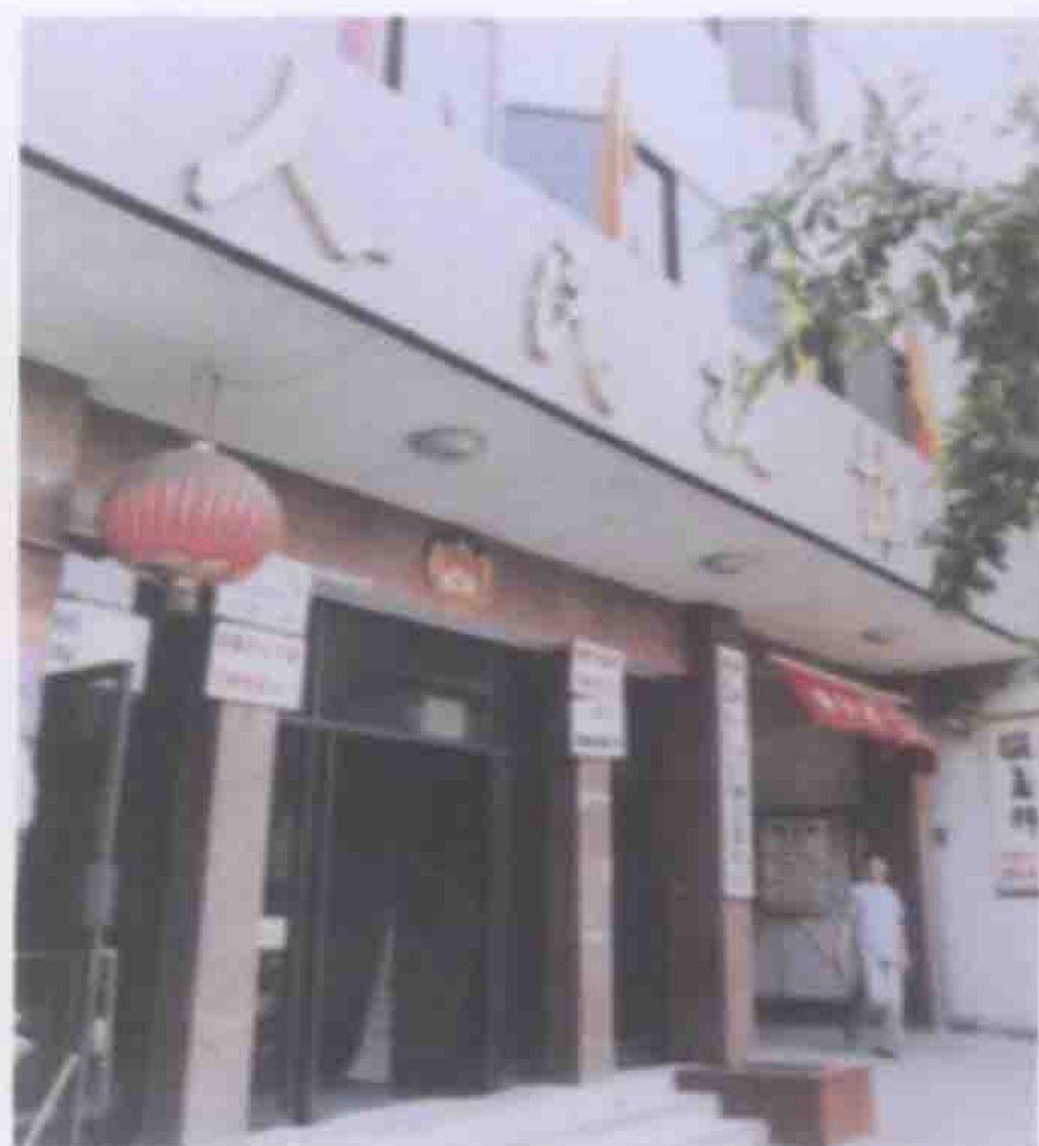
江津县政协办公大楼
