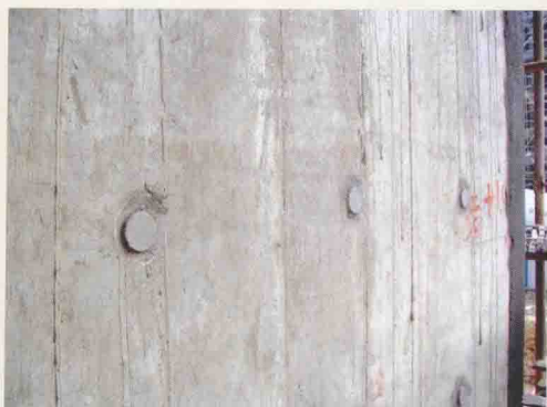
混凝土外墙螺杆孔1:1水泥砂浆封堵
