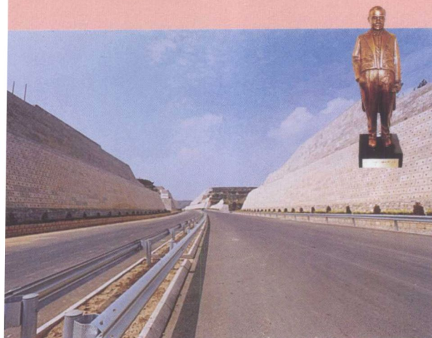
集团公司参建的山西祁临高速公路获中国土木工程“詹天佑”奖
