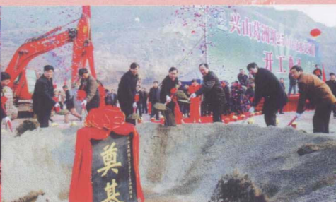
2月16日，兴山日产2500吨熟料新型干法水泥生产项目开工。
