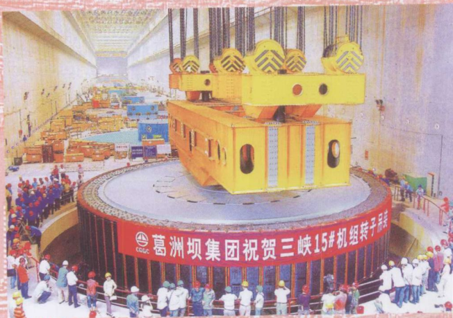
9月8日，三峡右岸电站最后一台机组转子吊装就位，进入总装。
