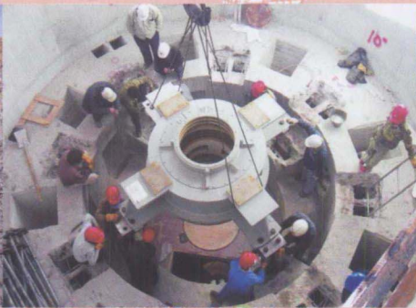
伊朗莫拉萨得拉2号机组安装现场
