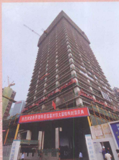
7月25日，“上海葛洲坝大厦”封顶。
