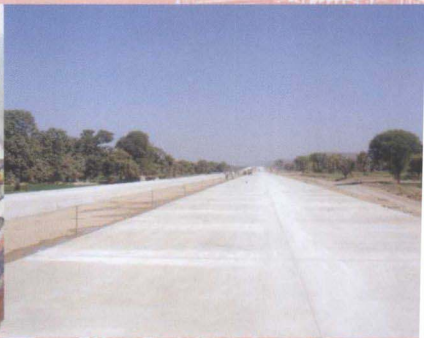
印度东西走廊RJ6标段路面全线贯通
