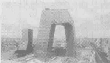
(c) 中央电视台大厦
