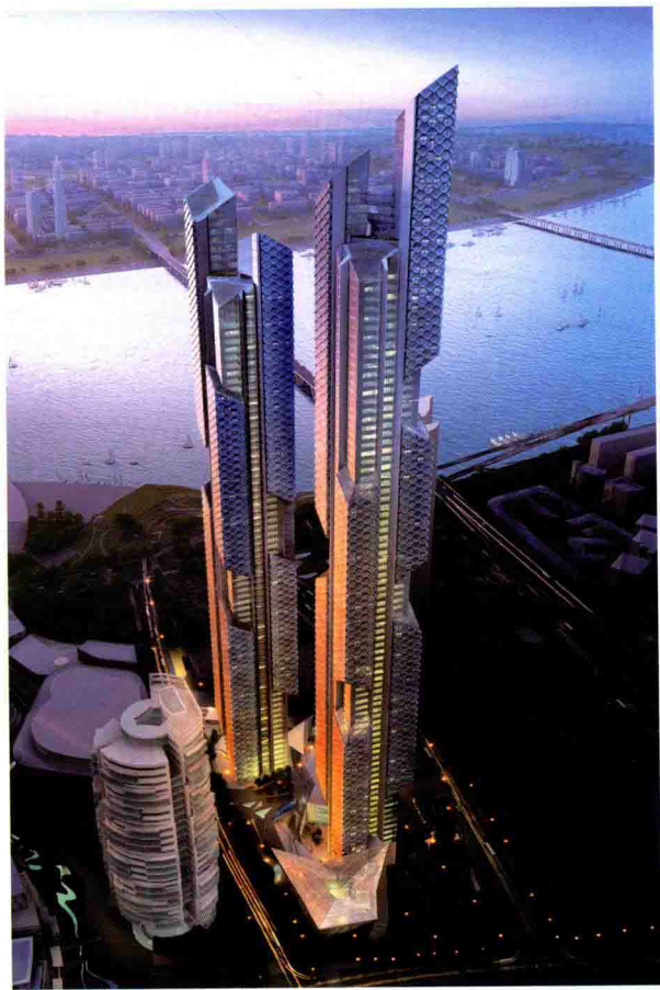
韩国首尔的龙舞大厦是一座地标性超高层双塔建筑,漂浮于主体之外的斜对角体块为人们提供了生活空间。这种建筑外墙设计是在模拟神龙的鳞片,同时起到通风的作用:相互重叠的盖板之间留有空隙,形成可以控制空气流通的通风口,使得建筑表层可以像动物的皮肤一样“呼吸”。
