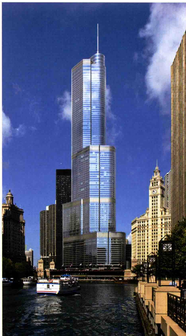
特朗普国际大厦酒店(2009年)是史密斯在SOM事务所工作时设计的,由高度参差的三部分构成。它的外观形态与芝加哥河边比邻的大楼(即瑞格利大厦、百丽广场、河畔公寓,以及北沃巴什330号大厦)交相辉映。大厦专门做出相应规划,在整体工程结束之前,酒店和停车场就可以投入使用,所以这座超高层建筑在建造期间就已开始盈利。
