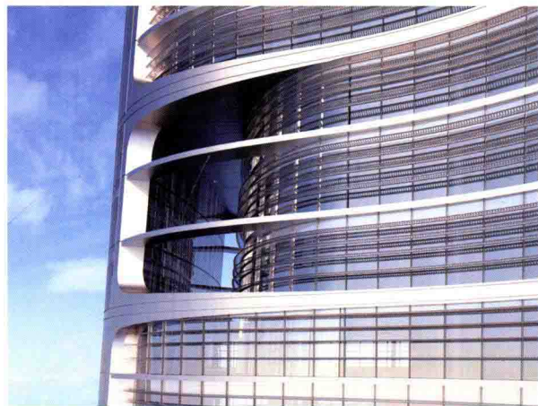
武汉绿地中心(预计2016年竣工)共119层,是一座综合性大厦,外观主要有三种形状——主体下粗上细,转角呈流线型,顶部是穹顶,这样的设计可以减小风压,空气动力学也使得结构材料用量降到最低。
