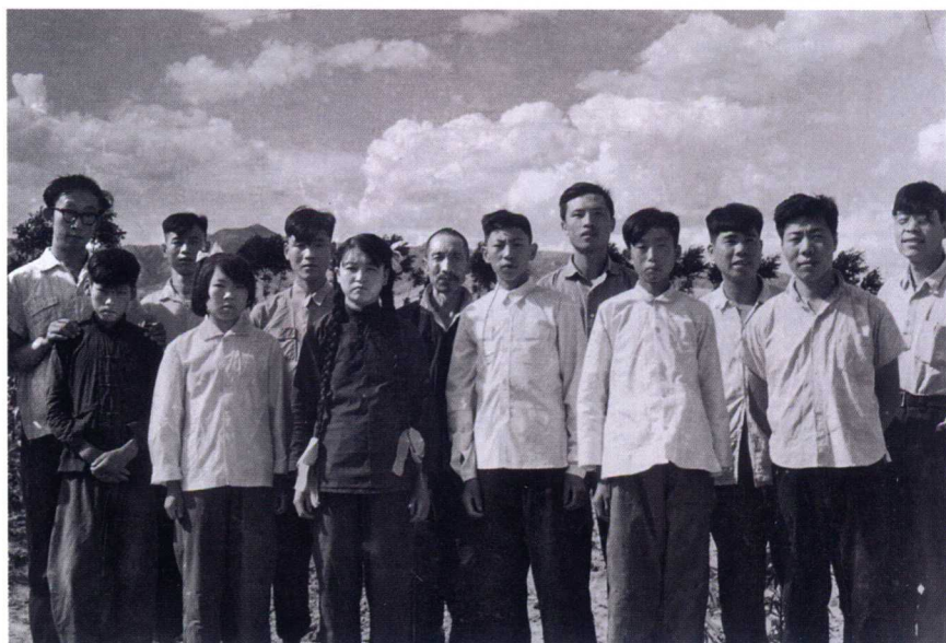
1961 年 7 月 于 内蒙古自治区宁 城县南山根遗址 工地
