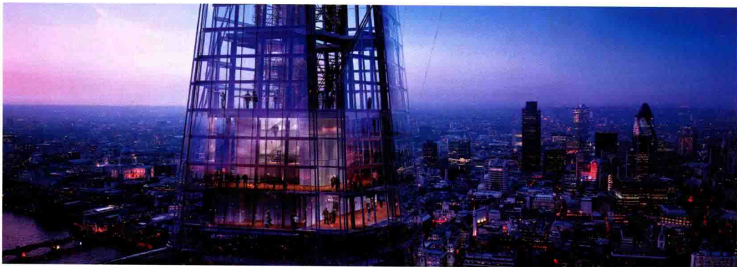
4. 伦敦桥中心 -102 设置于 68-72 层的公共观景平台拥有自己独立的地面入口
