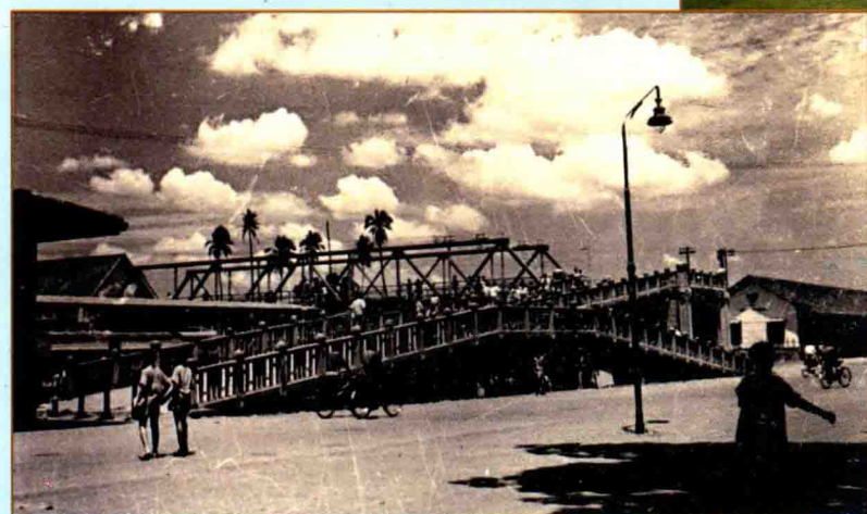
棉兰火车吊桥
