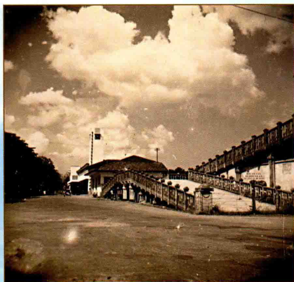
棉兰市火车站旁的行人吊桥
