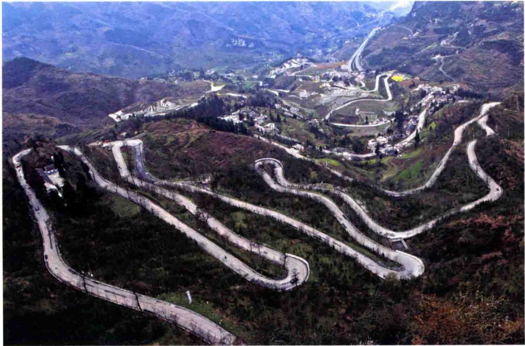
神州第一弯——凉风垭七十二弯公路奇观
