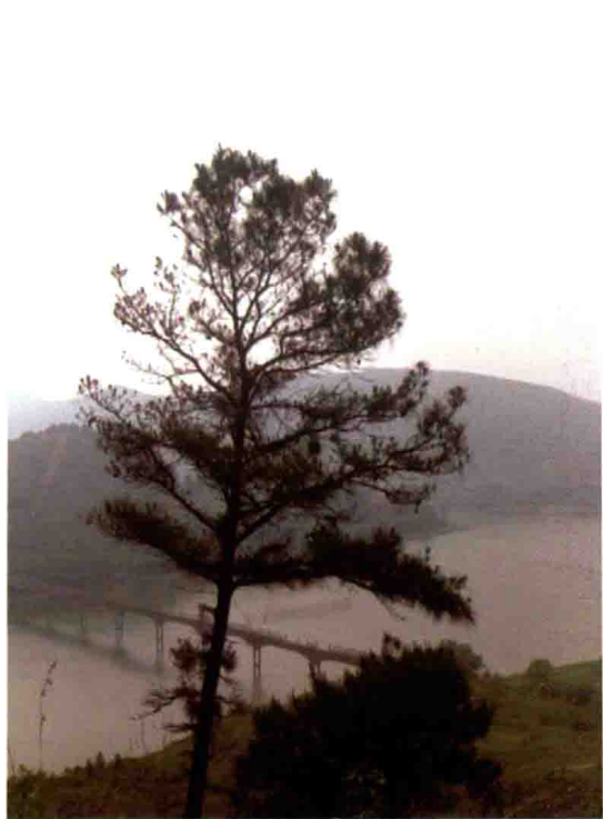
九龙引水渡槽
