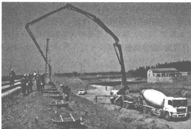
图 1-2-3 泵送混凝土
