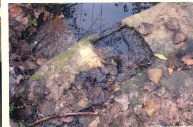
高池铺石桥柱孔
