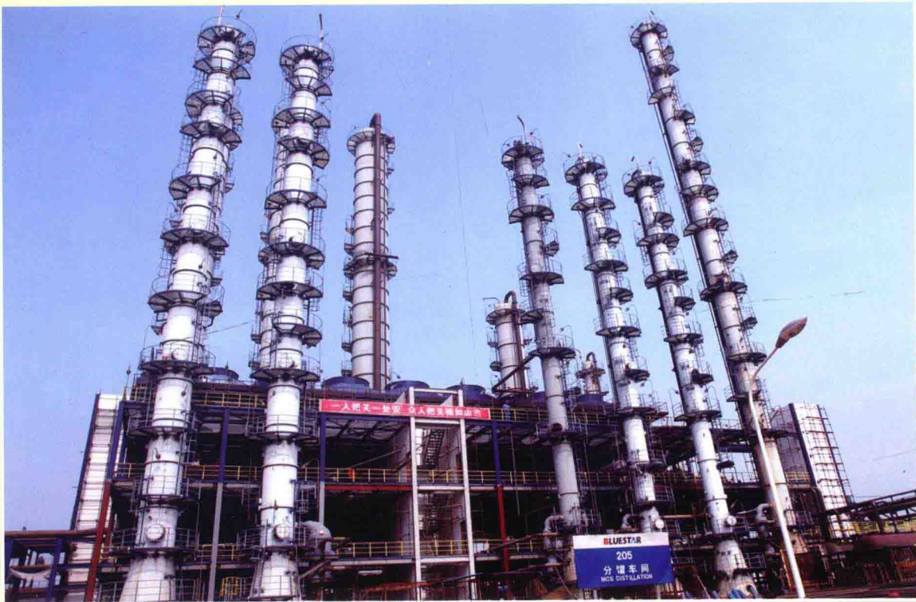
星火厂 20 万吨有机硅分馏车间
