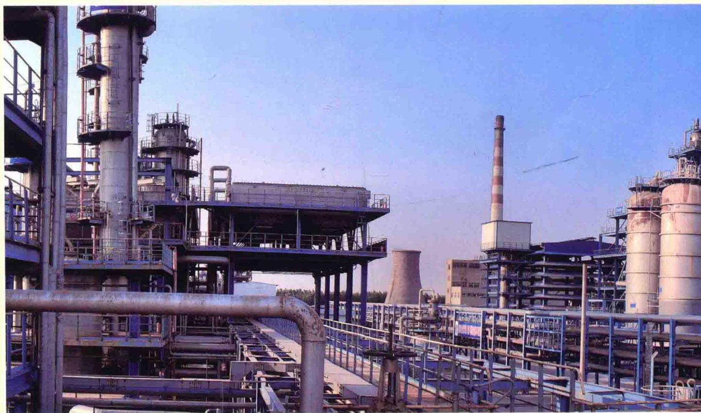
正和石化 DCC 联合生产装置
