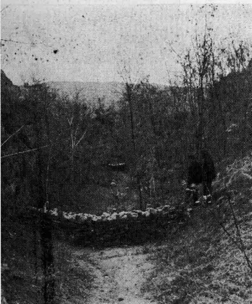
← 甘肅省天水市大柳樹溝經過溝坡植樹，溝底修筑柳石谷坊，已經基本上控制了水土流失。
