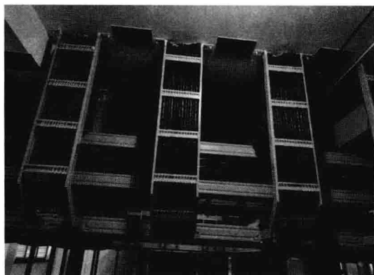
图 1-8 变电站二次电缆排列图
