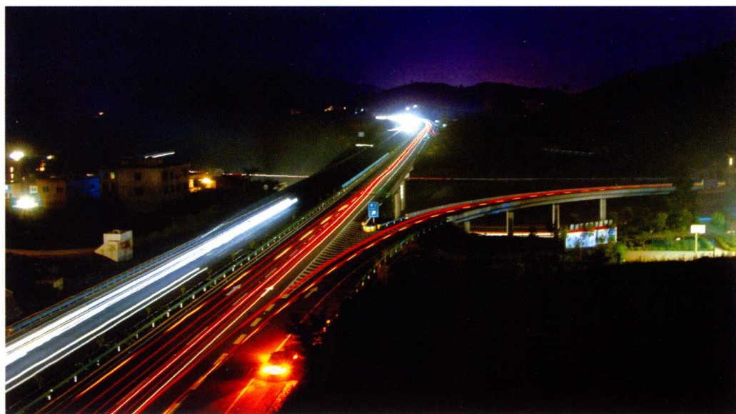
遵崇高速公路高桥段夜景。
