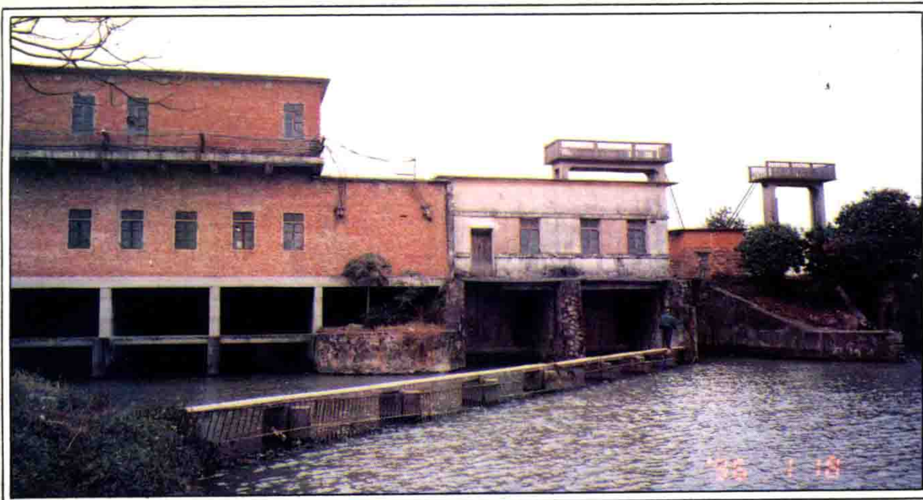
黄金围鸦岗水闸、电排站
