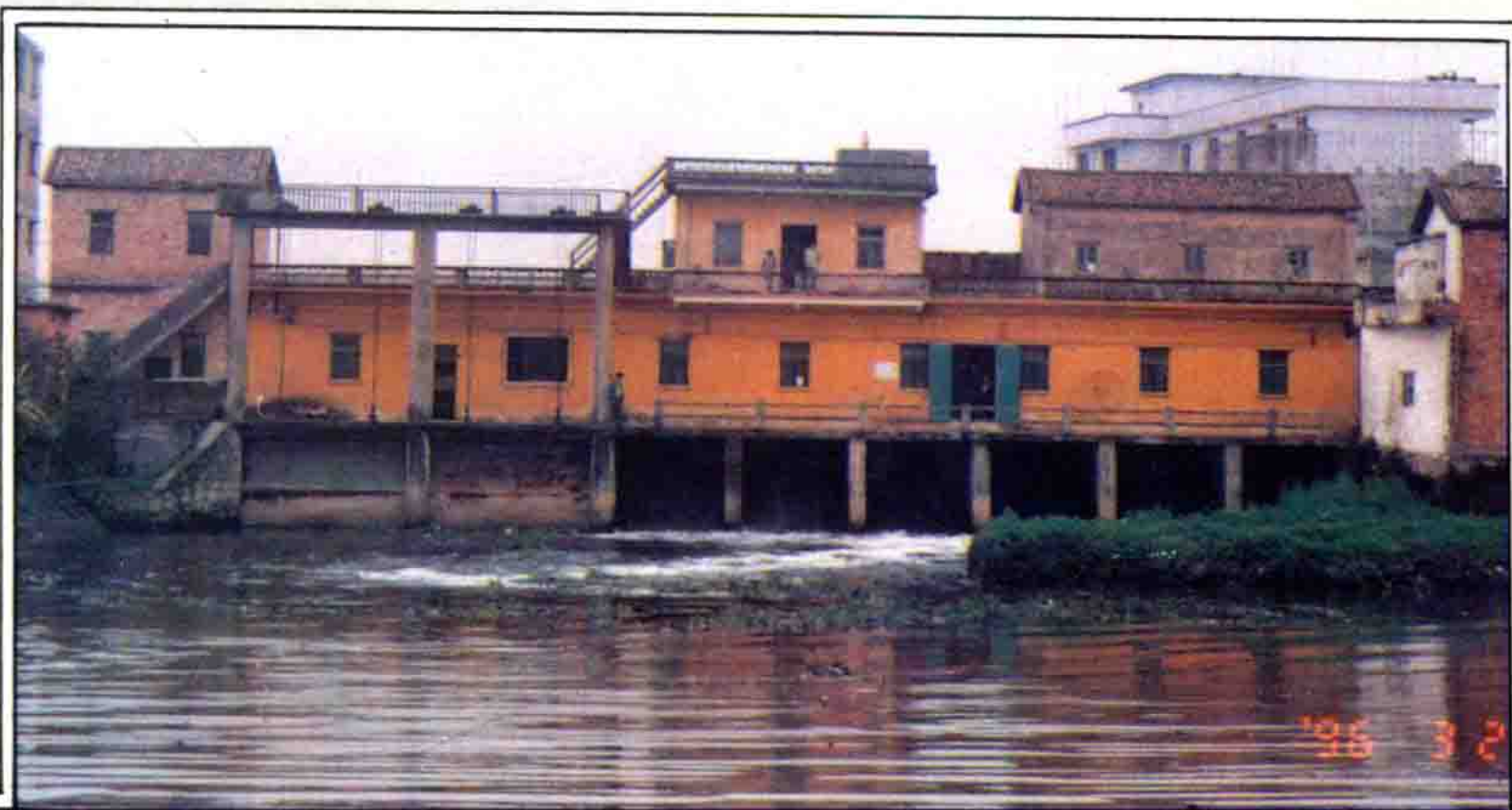
朗环水闸、电排站
