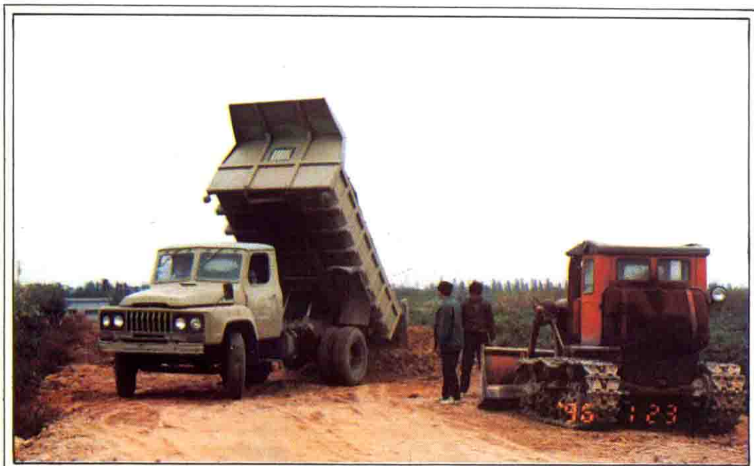
岭南围大堤加固工程
