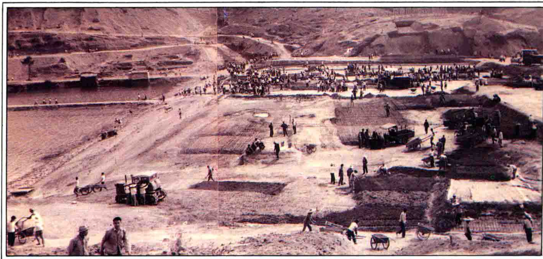
和龙水库施工期间
