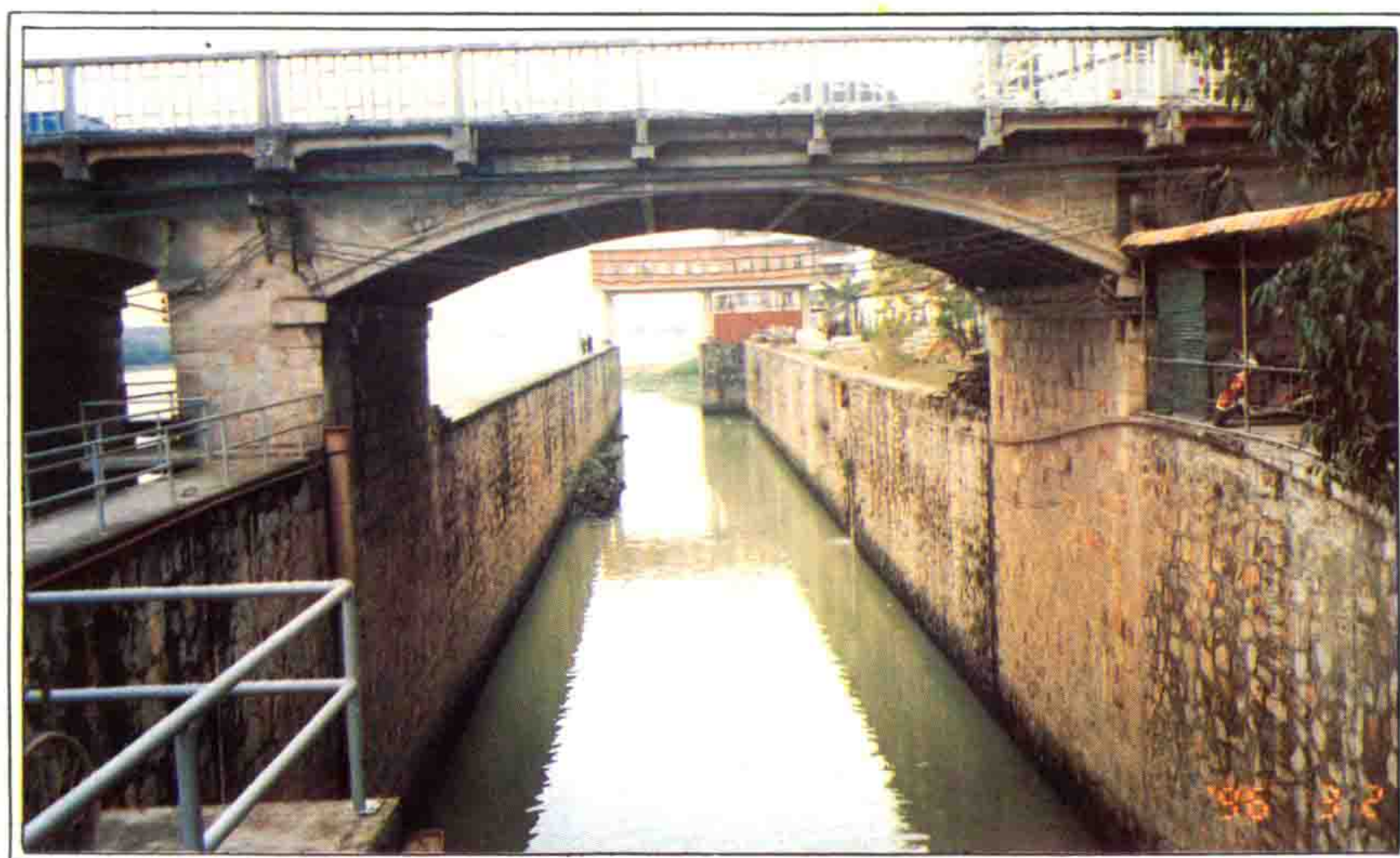
人和拦河坝 船闸 (闸室和下闸首)
