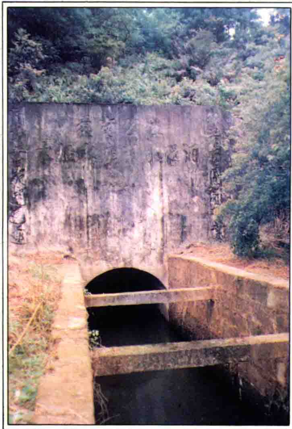
木樨引渠引水隧洞
