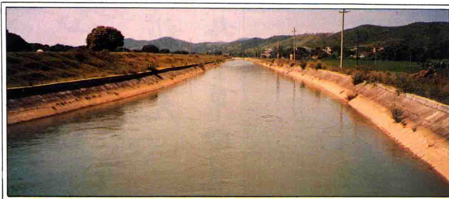
流溪河灌溉工程 右总干渠
