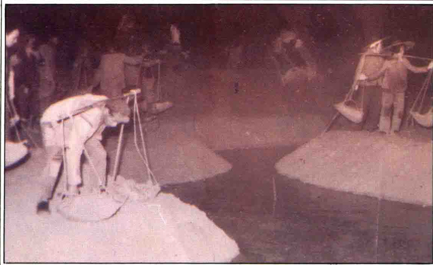
腰坑水库水中 倒土筑坝
