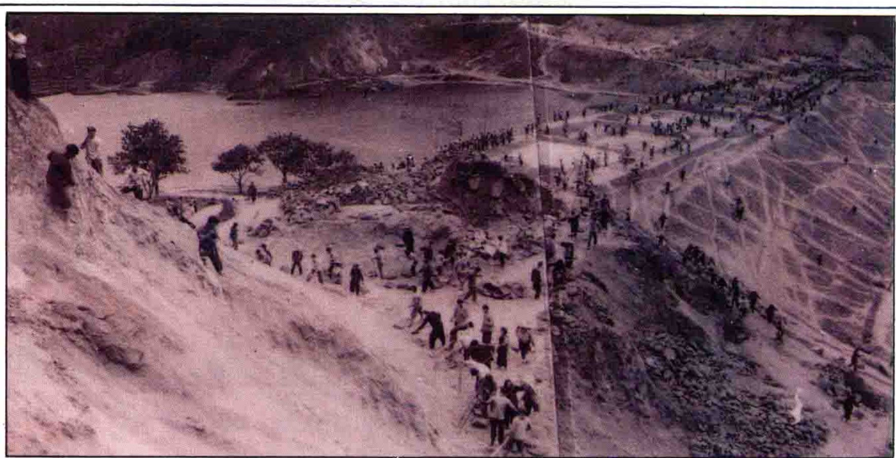
腰坑水库大坝 施工期间
