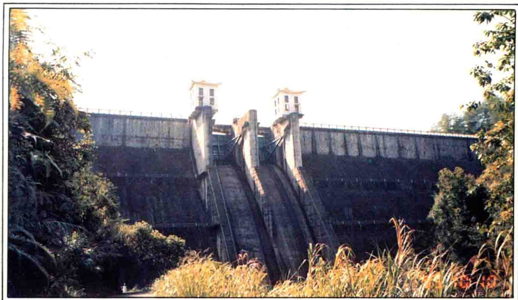
黄龙带水库大坝、溢洪道
