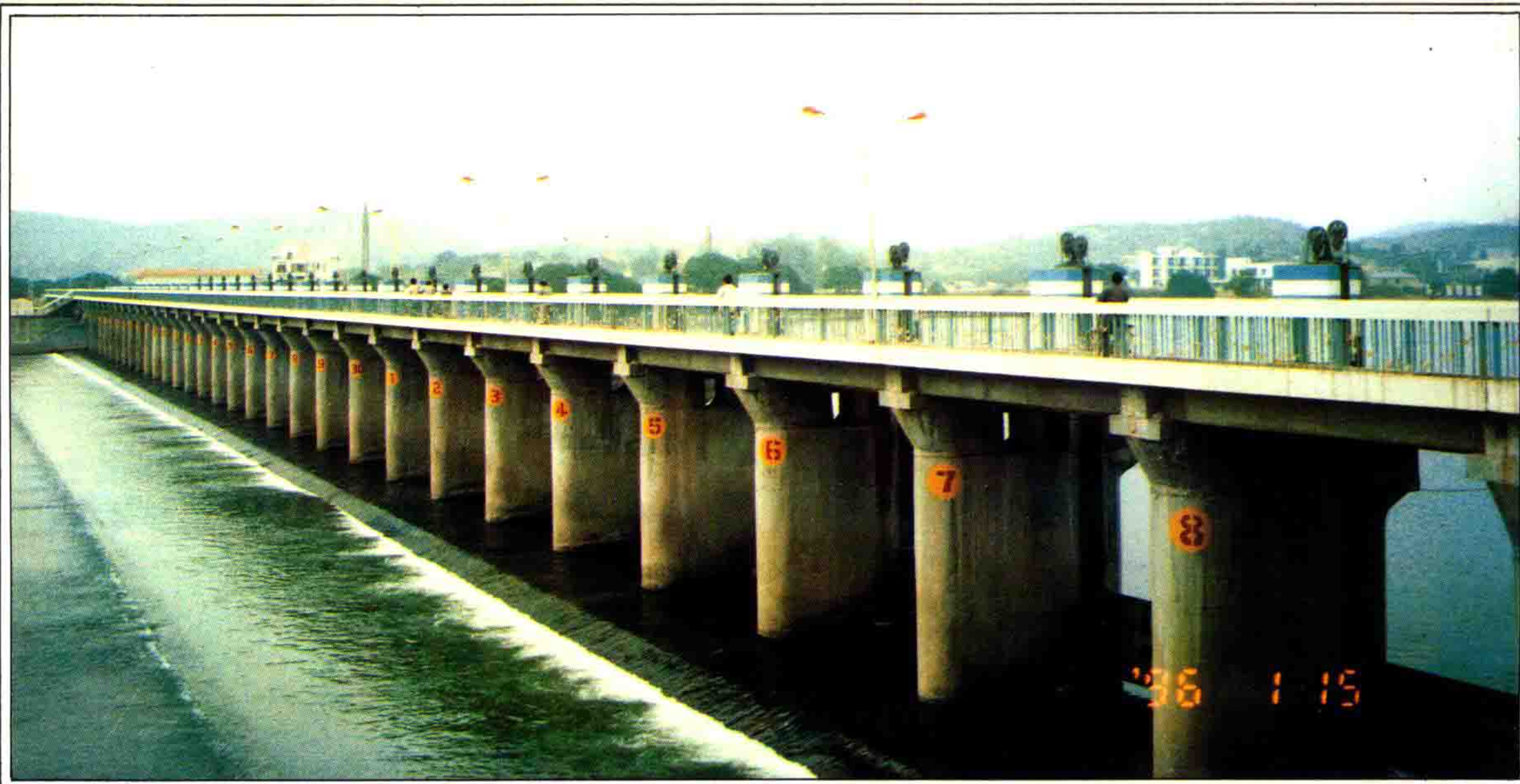
流溪河灌溉工程 大坳拦河坝
