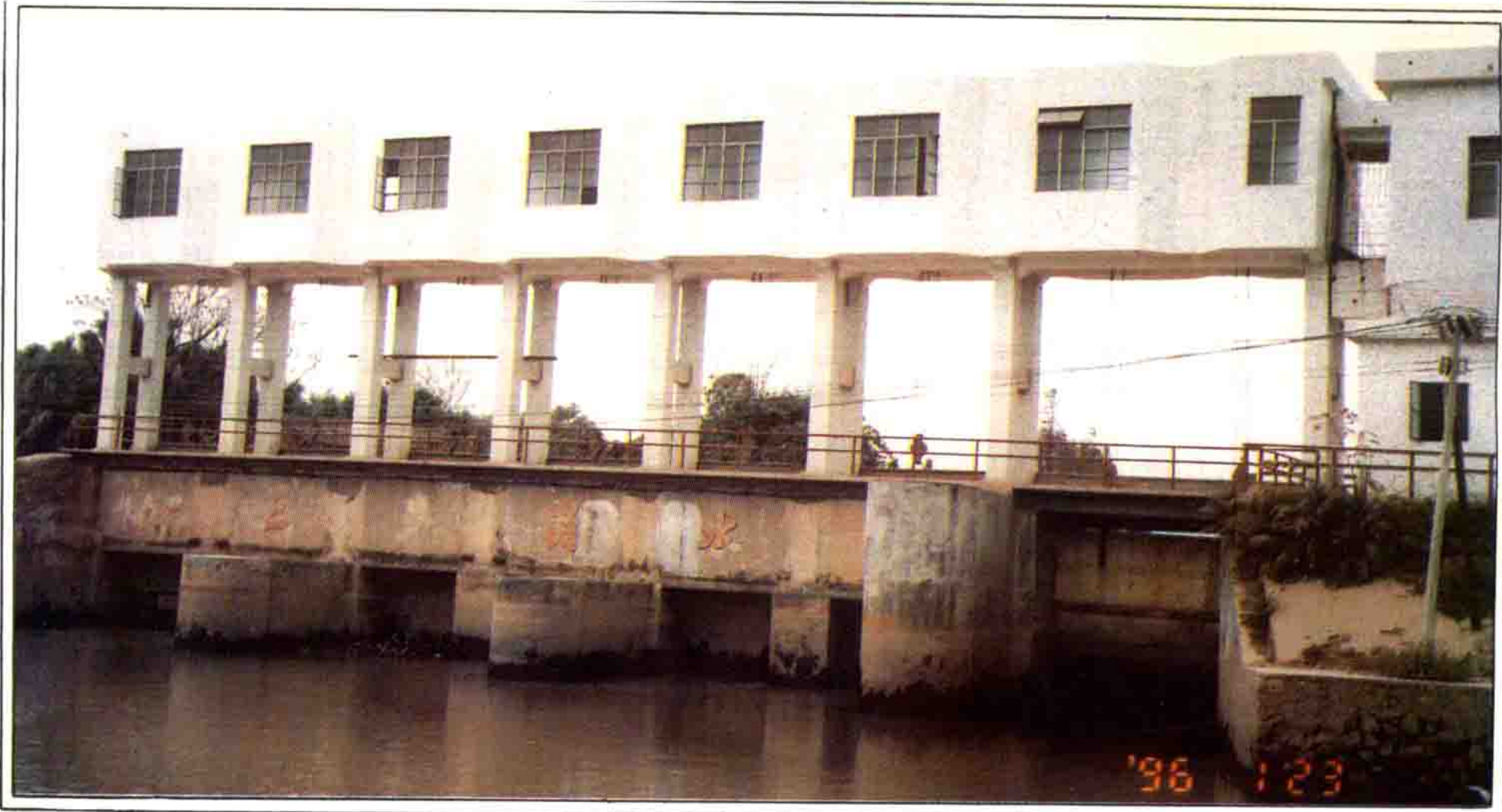
岭南围岗南水闸
