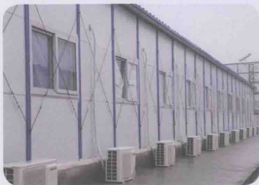
图1.3 工地用房搭设
