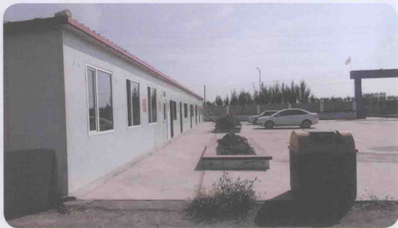
图1.5 卫生整洁的工地生活区
