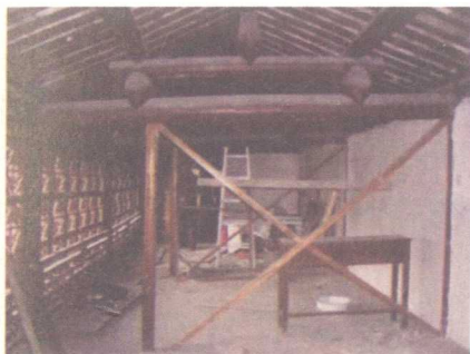
图 2.3 二层屋架西端出现沉降
