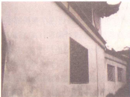
图 2.5 墙体下部粉刷层发黑
