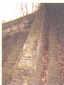
图 2.12 原竖带破损
