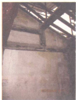
图 2.7 檐檩完全腐朽
