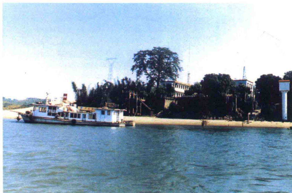
● 西江干流马口水文站，全站设备于1997年进行维修及更新，有机动测船两艘，配有先进的海流仪。图中右侧为该站办公楼，左侧为北江洪水调度中心的遥测楼
