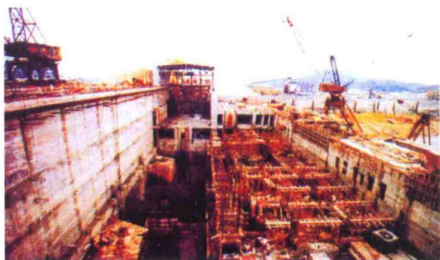
●1994年10月，飞来峡水利枢纽工程开工建设。图为1996年3月完成的基坑主体工程
