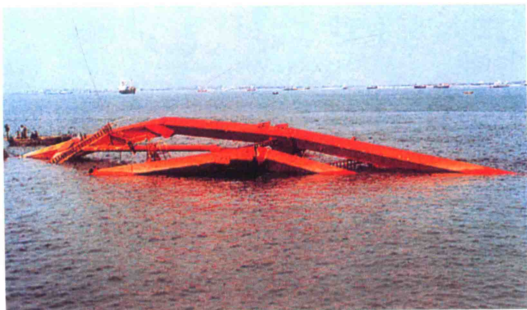
● 1996年9月，9615号台风将湛江港500多吨的集装箱卸吊桥吹下海里
