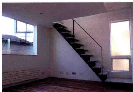
省去顶角线，将天花板和墙壁的表面装饰进行统一的施工案例（参创 HOU-TECH）
