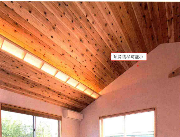
天花板和墙壁简洁处理的施工案例（北村建筑工房）
