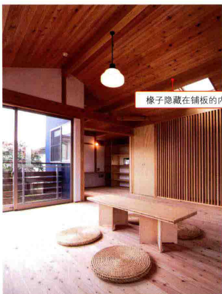
铺有木板的天花板。除主房和大梁之外的部分都未外露, 所以完成的效果很简洁
