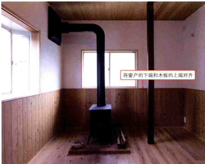
铺有木板的拱肩墙的案例。与粉刷墙的组合看起来简洁大方 (辉建设)
