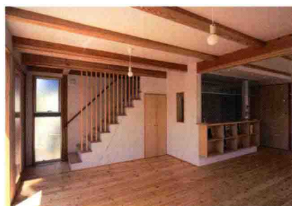
起居室和楼梯间的隔墙使用竖向百叶窗的施工案例（上图 冈庭建设） 竖向百叶窗兼作楼梯扶手的施工案例（下图）
