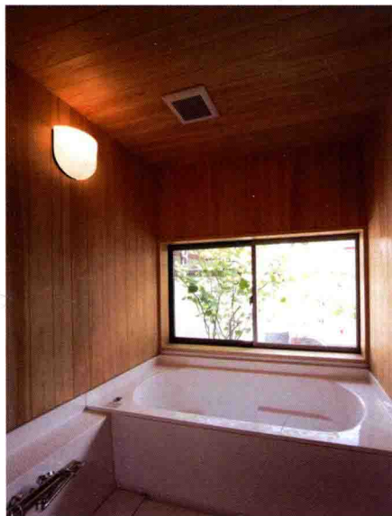
使用单体浴缸的铺有木板浴室的案例。 省去顶角线，看起来更加简洁（冈庭建设）
