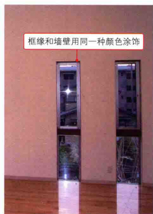
控制裂隙状的窗户四周的框缘的宽度的施工案例（元德建工）
