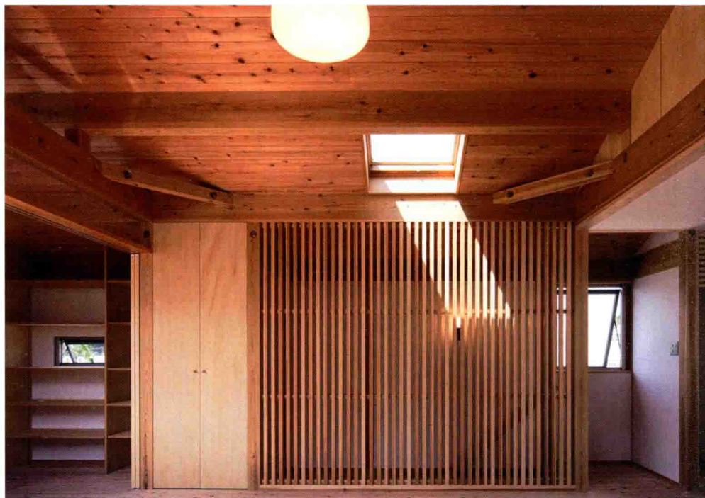
起居室和楼梯间的隔墙使用竖向百叶窗的施工案例（上图 冈庭建设） 竖向百叶窗兼作楼梯扶手的施工案例（下图）
