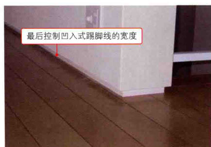
根据上图的布局设计的凹入式踢脚线的施工案例。通过阴影给人以深邃感（千岁之家）
