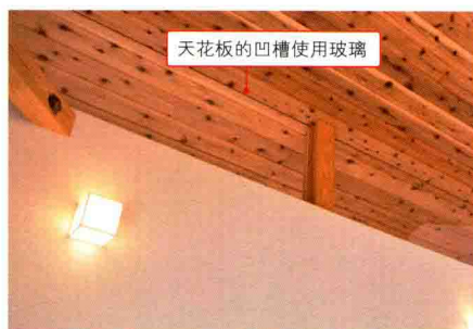
隔墙上面的栏间部分嵌入玻璃的施工案例。因为没有边框，腾出更大的空间（北村建筑工房）
