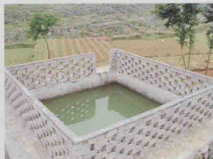
2005年，全面启动以烟水工程和密集烤房建设的烤烟生产基础设施建设
