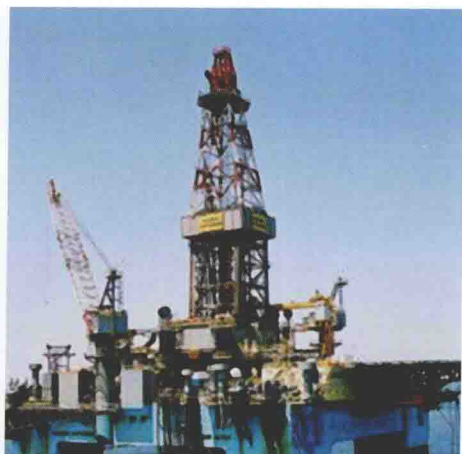
图 4-1-4 石油钻井平台
