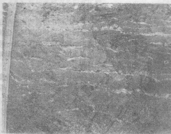
圖 1.1 冷库地面下的冻土
