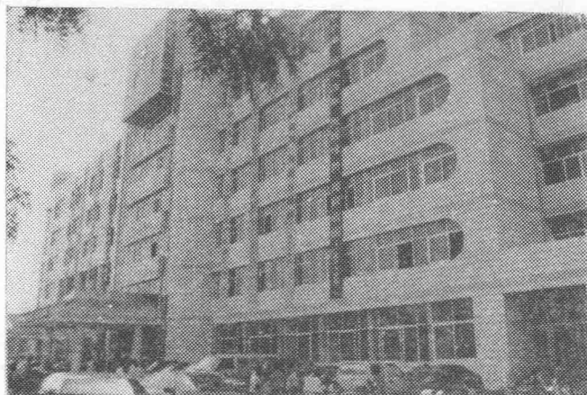
新落成的医院门诊大楼
