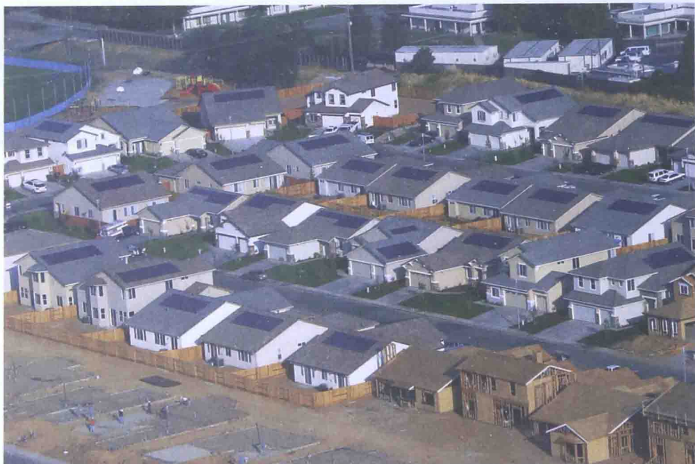
安装在城市新开发区的光伏系统
