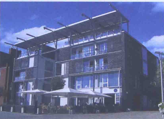
光伏遮阳集成到建筑设计上 资料来源：© Hespul
