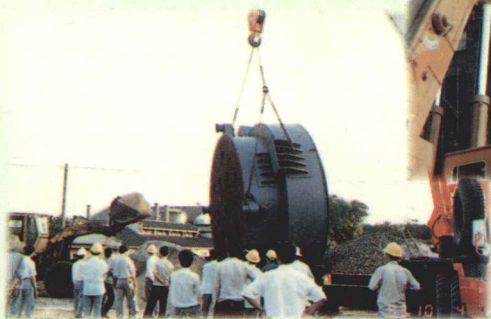
■ 广丰糖厂 6000 扩建工程、2700 平方蒸发甌吊装
