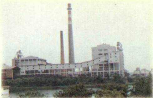
■ 广前公司新建 75 T /时锅炉车间
