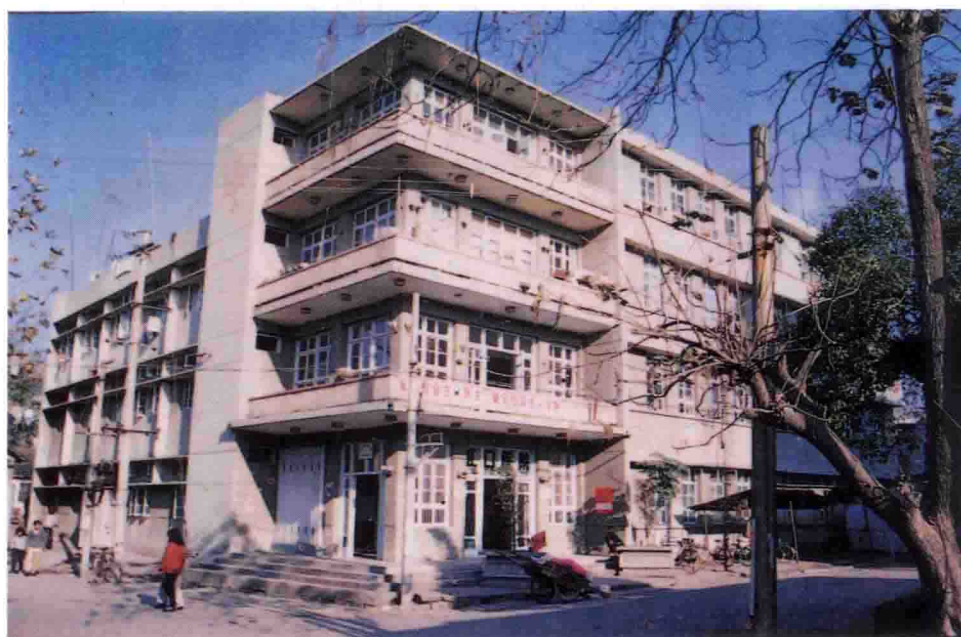
江口中心卫生院门诊部
