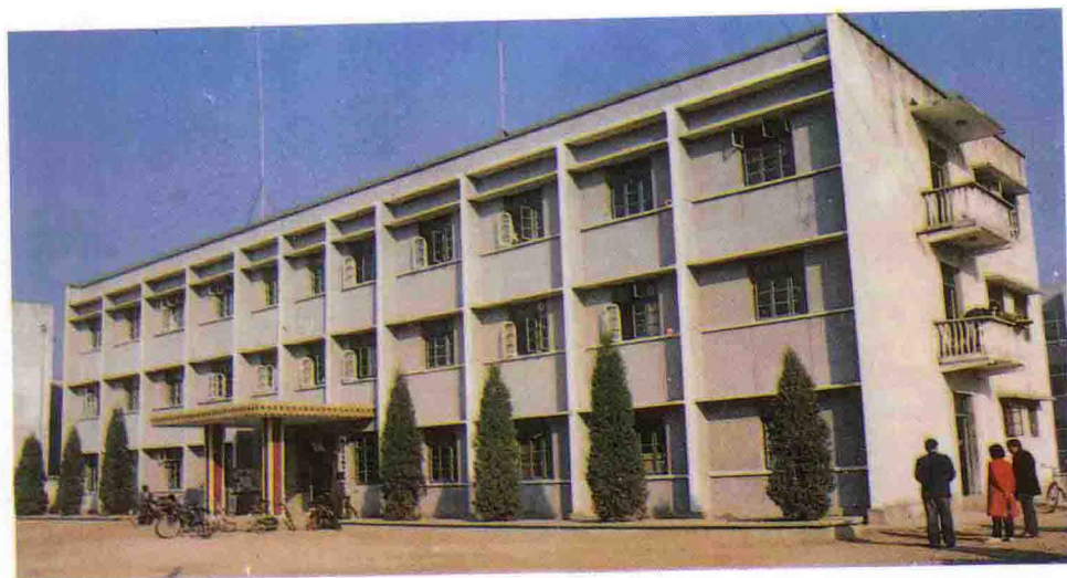
安福寺中心卫生院门诊部
