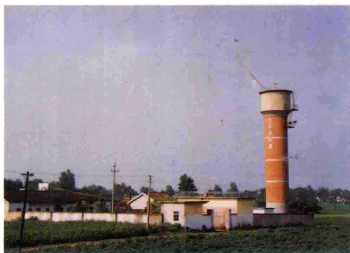
七星台陈家港村水厂外貌
