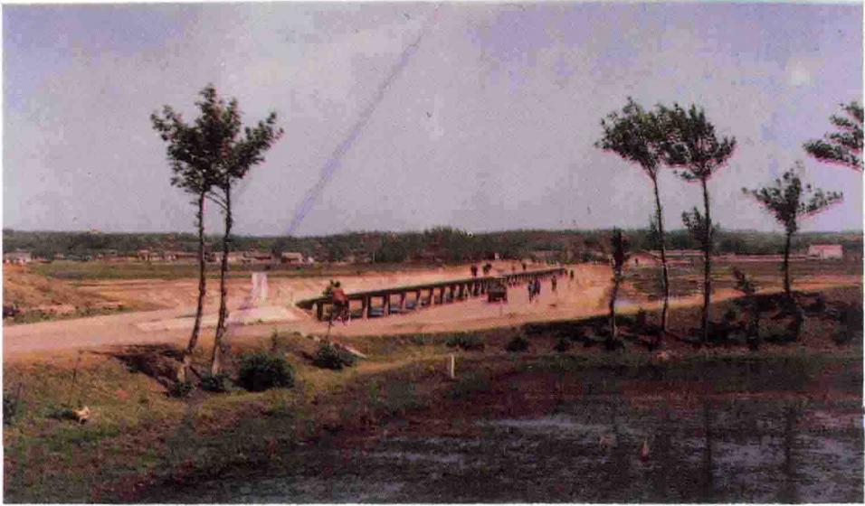
玛瑙河灭螺工程二道坝
