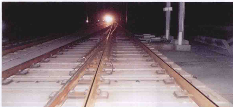
图 1-2-6 板式无砟轨道图
