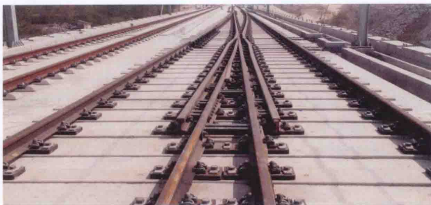
图 1-2-5 长枕埋入式无砟轨道图
